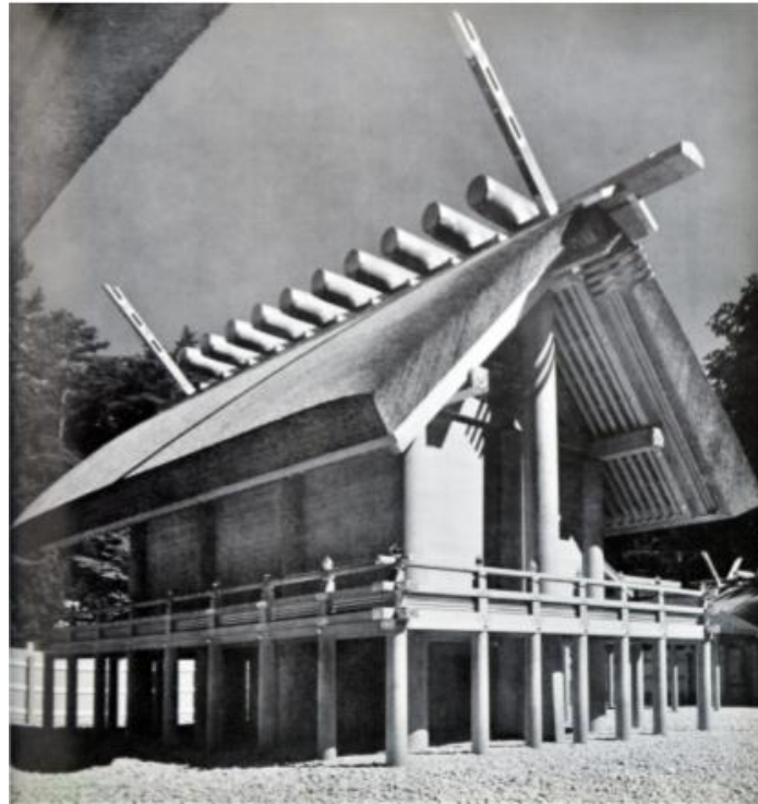
Figura 18: Naiku , parte do complexo de Ise-Jingu . Fonte: Tange & Kawazoe, 1965.
