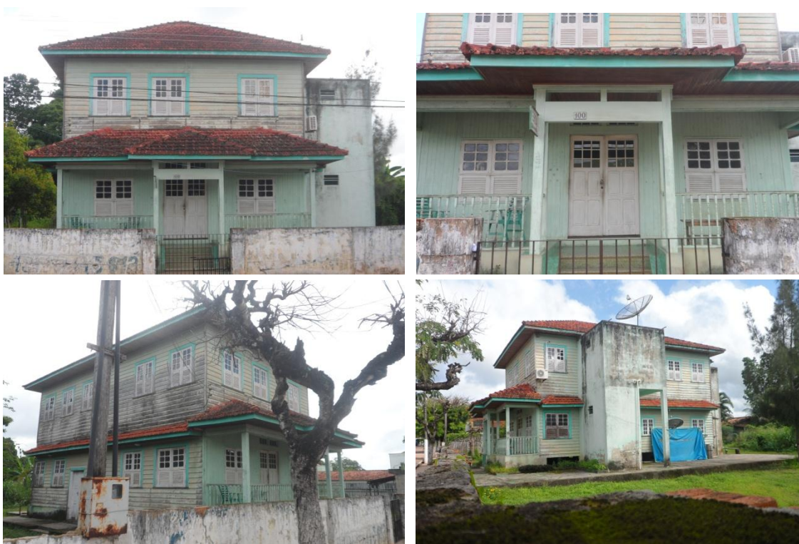
Figura 47: aspectos distintos da Casa Eguchi, em Tomé-Açú, Pará. Na tomada geral, a mencionada “estrutura de alvenaria” sobre a qual me debruçarei mais adiante. Fonte: Autor, 2016.
