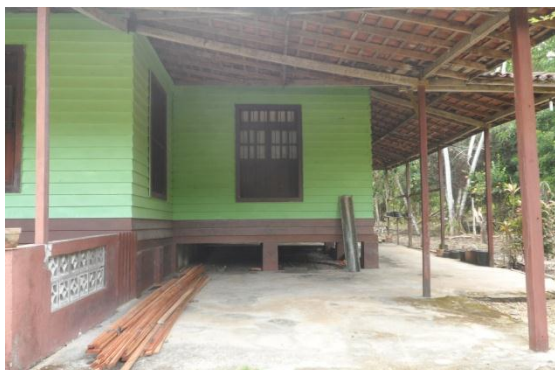
Figura 23: detalhe do vão entre o assoalho e o terreno na casa da família Kudo. Fonte: Autor, 2016.
