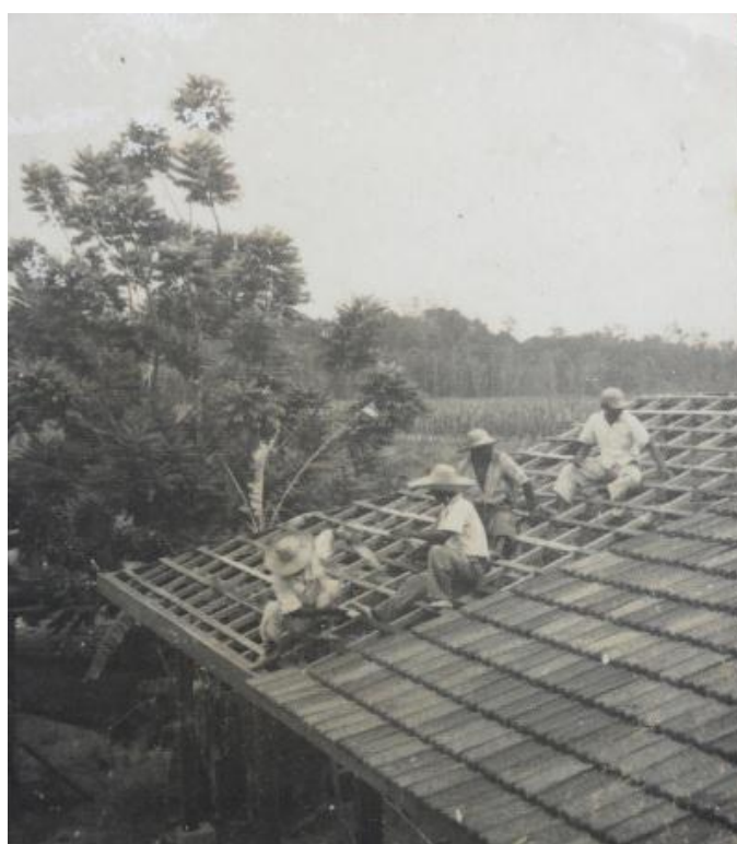
Figura 39: a execução do telhado marcava o final da primeira fase de construção da casa, quando o esqueleto finalmente coberto era então finamente preenchido pelo mestre carpinteiro. Fonte: Hajime Yamada, 1954.
