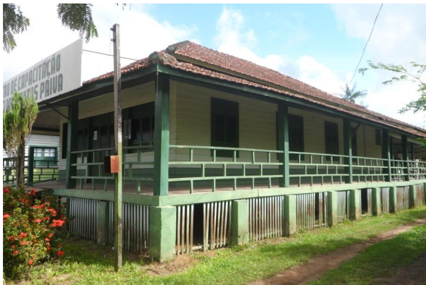
Figura 4: o Centro de Capacitação “Juraci dos Santos Paiva”. Fonte: Autor, 2016.
